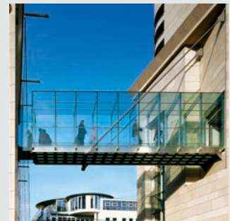
■ Puente de vidrio Karstadt-Kaufhaus, Dortmund
